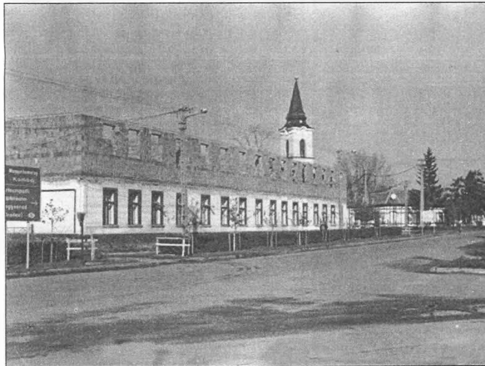
Lucrările de reconstrucție a școlii din Săcal au ajuns într-un stadiu avansat
