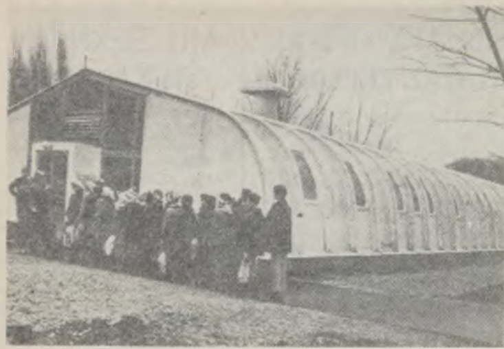
Τό Λαϊκό Συμβούλιο του 13ου διαμερίσματος της Βουδαπέστης κατασκευάσε στο γυμνάσιο «Κίλιαν Γκέργκν» σκεπαστή κολυμβητική δεξαμενή, που θα χρησιμοποιείται από όλα τα σχολεία του διαμερίσματος. Στόν καθηγητή "Ισβαν Τσιέρ" ανατέθηκε τό καθήκον νά μάθει όλους τούς μαθητές τού διαμερίσματος νά κολυμπούν.
