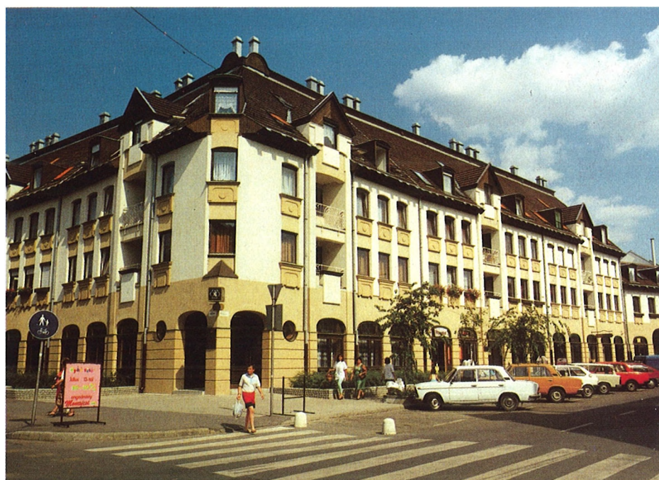
Moderná nová budova na rohu ul. Munkácsyho a Andrássyho s malými obchodmi, bankou...
