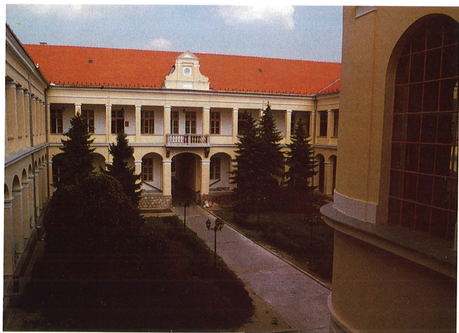
Budova mestského domu v tomto roku je 120 ročná.
